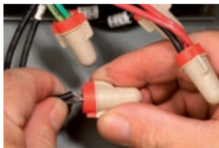
Našroubování konektoru na vodiče
